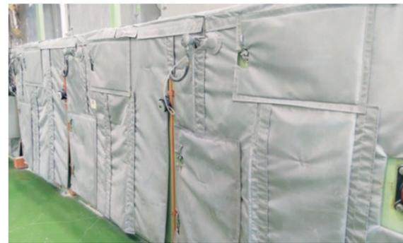
乾燥設備へ保温ジャケット設置
