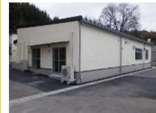
高純度赤燐の新生産棟 (2022年竣工)
